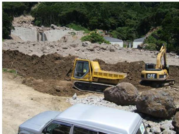
写真 4.3.17 遠隔操縦による危険箇所での
